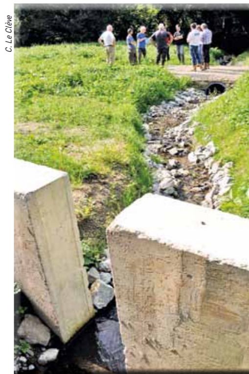
A Restaudran, un ouvrage répartiteur (au 1 er plan) permet d'assurer l'efficacité du dispositif de franchissement en toutes saisons.
