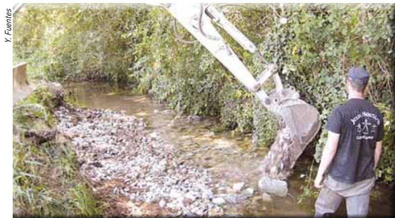
Le Scave : la reconstitution de radiers au moyen d'une granulométrie adaptée permet de reconstituer une alternance d'habitats tout en recréant des zones propices aux truitelles et autres petites espèces d'accompagnement.
