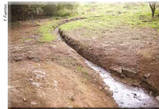
Le Léthy : la section du nouveau tracé a volontairement été sous-estimée afin de permettre au Léthy de retrouver une section d'écoulement conforme à son gabarit naturel d'équilibre.
